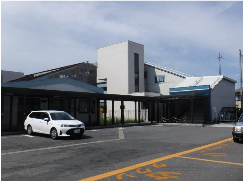
写真 五泉中央連絡橋の整備状況
