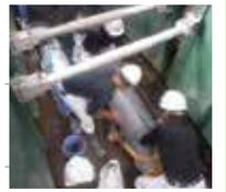
老朽化した水道管を災害に強い耐震管に更新する様子
