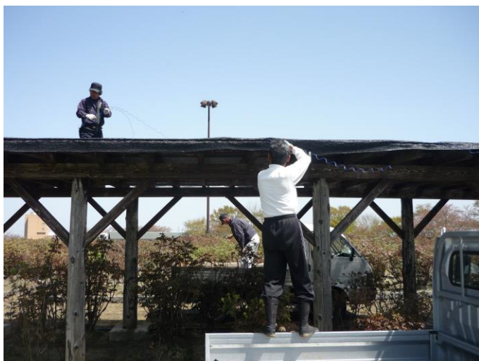
遮光ネット設置作業
