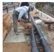
災害に強い耐震管に 布設替える様子
