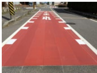
安全性の向上を図るためにカラー舗装された交差点
