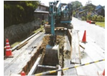
下水道工事の様子
