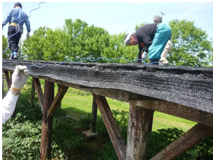
遮光ネット設置作業
