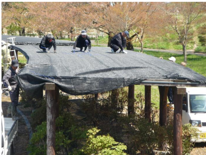
遮光ネット設置作業
