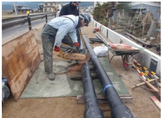
老朽化した水道管を災害に強い耐震管に布設替える様子
