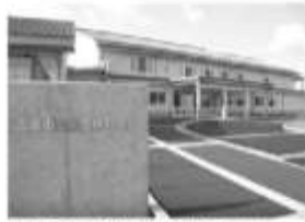
五泉市立総合体育館を建設しました。
