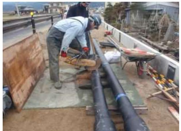
老朽した水道管を災害に強い耐震管に布設替えする様子
