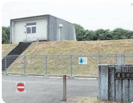
配水池(五泉配水池)
