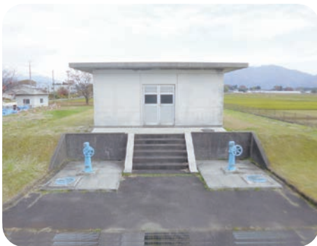
浄水池(五泉浄水場)
