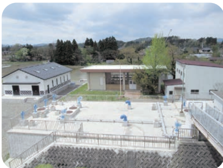
浄水池(村松浄水場)
