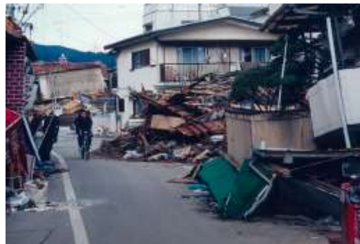
参考：地震後の道路閉塞の状況
