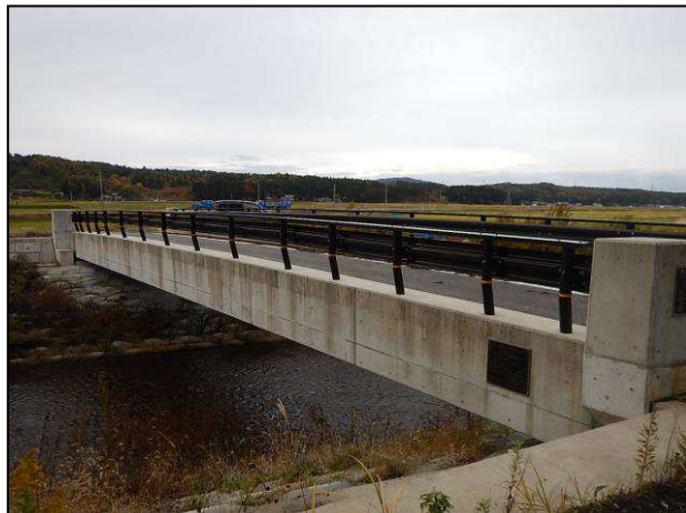
写真全景（コンクリート橋）
