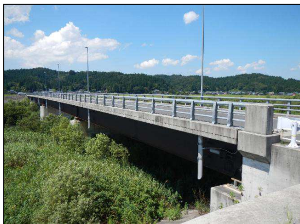
写真全景（鋼橋）
