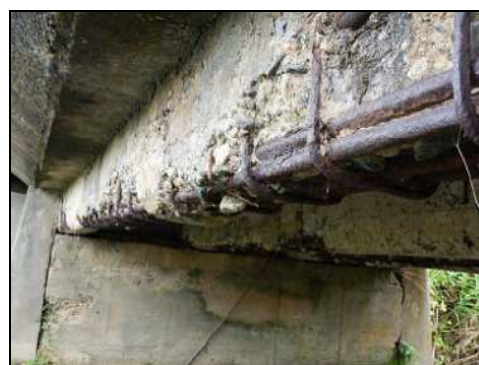
コンクリート橋の剥離・鉄筋露出等
