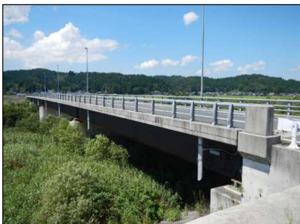
写真全景（鋼橋）
