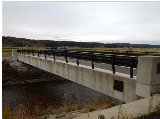
写真全景（コンクリート橋）
