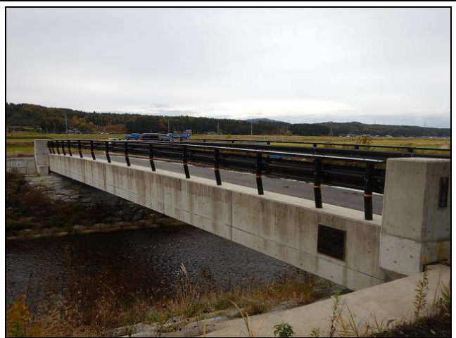
写真全景 (コンクリート橋)
