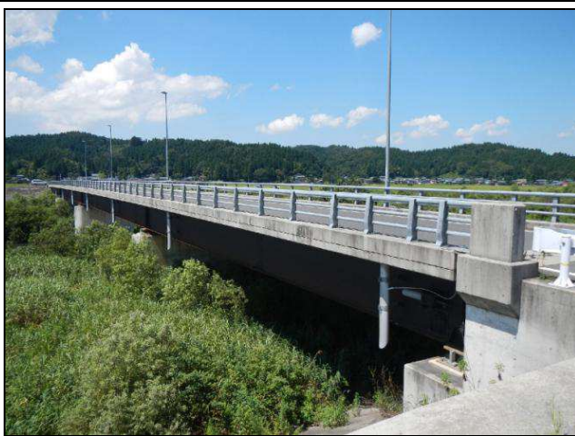
写真全景 (鋼橋)
