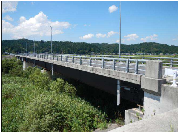
写真全景（鋼橋）
