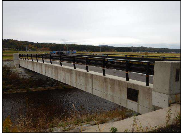
写真全景（コンクリート橋）
