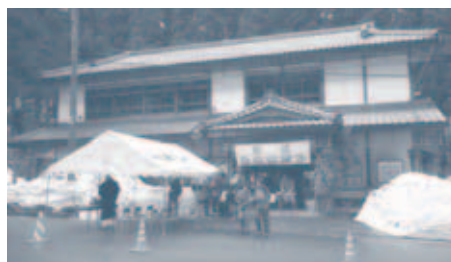
五泉市村松黄金の里会館（蛭野地内）
