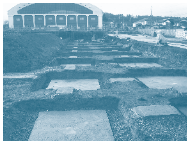
(仮称)村松体育館建設予定地
