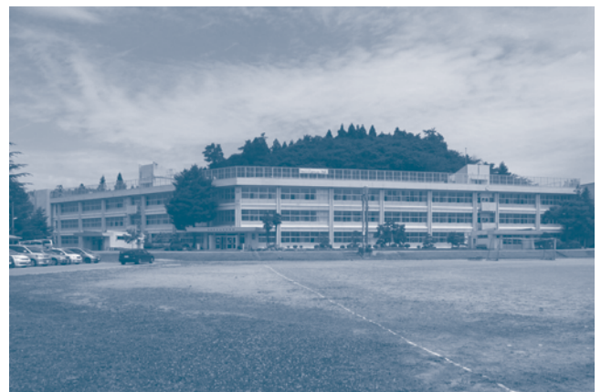
耐震化が図られる山王中学校
