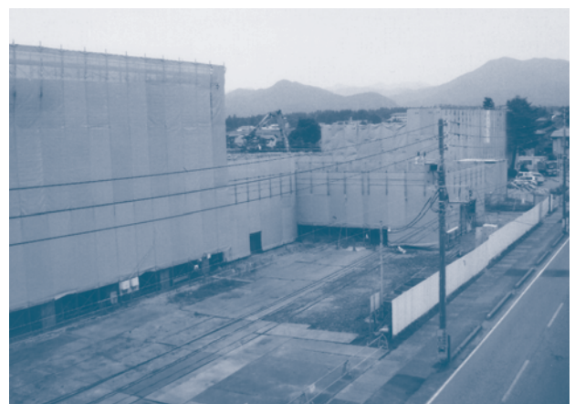
(仮称)村松体育館の建設現場 (撮影日)平成21年6月29日
