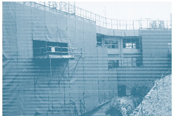
山王中学校校舎棟耐震補強工事
