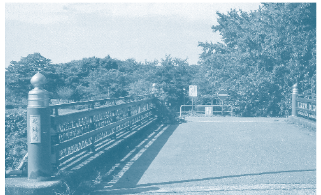
架替予定の「城跡橋」
