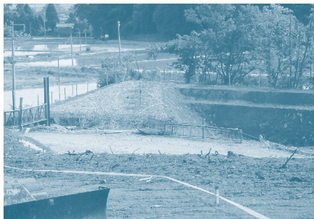
上大蒲原の土採取現場
