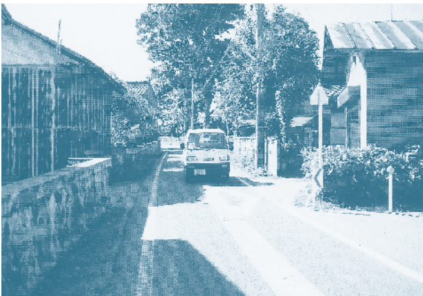
五泉停車場石曾根線の道路
