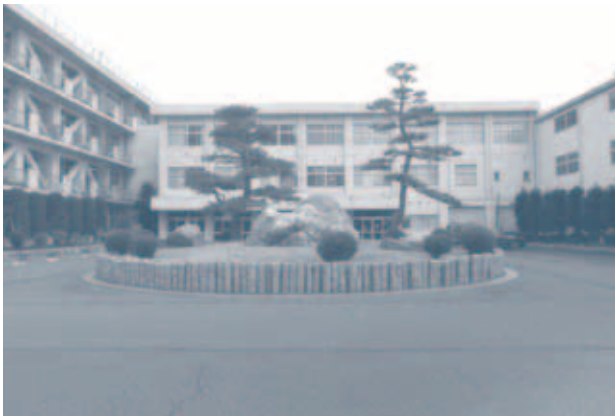
大規模改修が予定される五泉中学校
