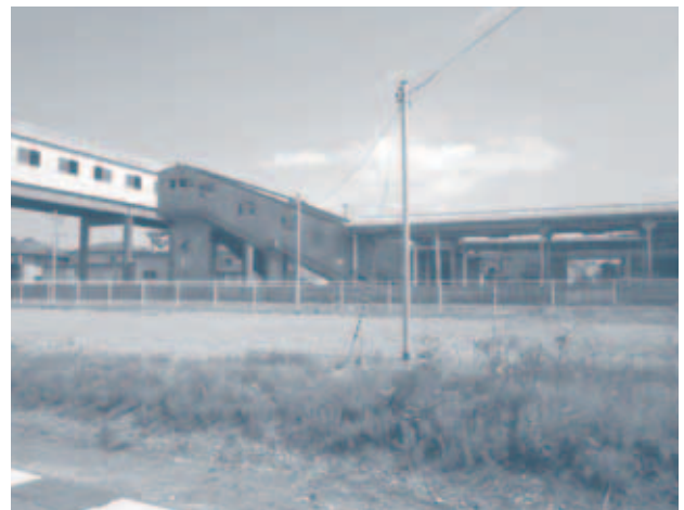
五泉駅南側・連絡橋と仮設駐車場
