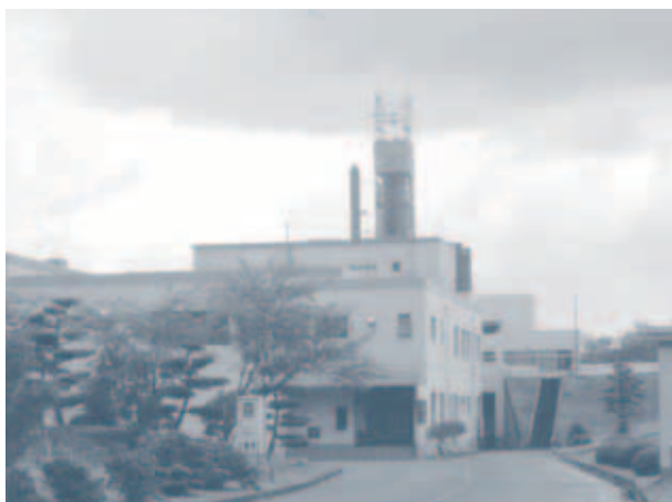
五泉地域衛生施設組合・可燃物焼却場（煙突修理）
