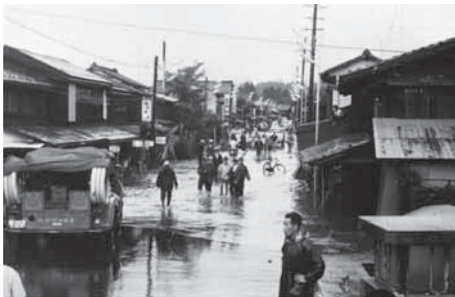
▲浸水被害の様子（城町地内）
