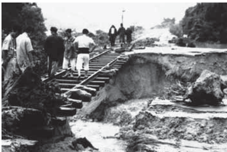
▲雨が土砂を洗い流し、磐越西線のレールを宙づりに（馬下・下谷地内）
