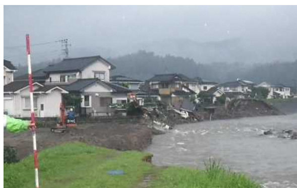
河岸侵食による家屋の倒壊(花月川)
