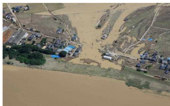
堤防決壊による家屋の流失(鬼怒川)
