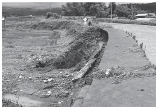
18日、中野橋地内の能代川で水が溢れ、堤防のり面が流される被害が発生。被害発生当日から翌朝にかけて、県による緊急的な応急工事を行いました。
