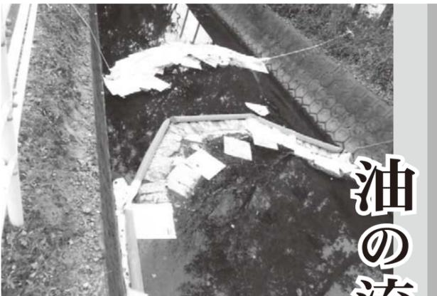
▲油の流出で汚染された河川。応急処置でオイルフェンスを設置。（県内での事故例）
