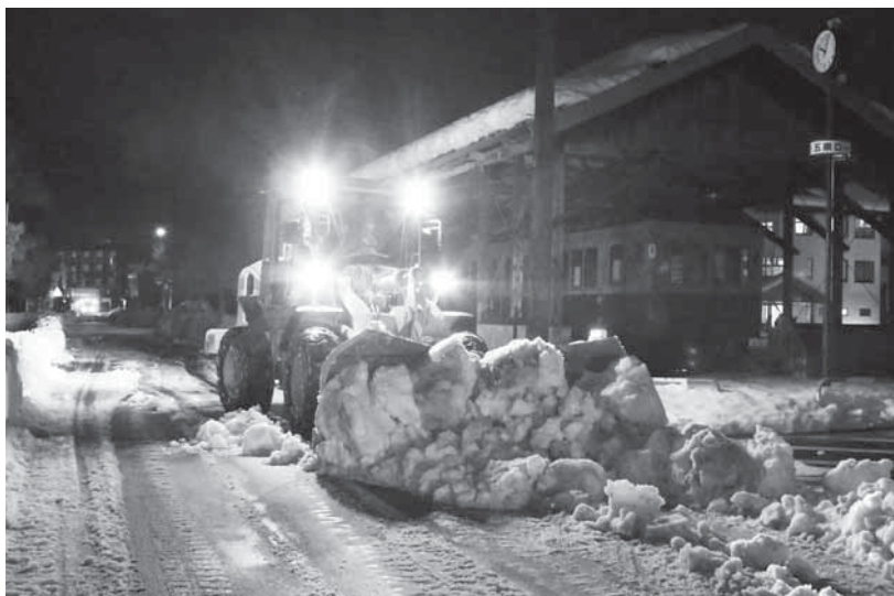
▲除雪作業の様子（栗島地内）
