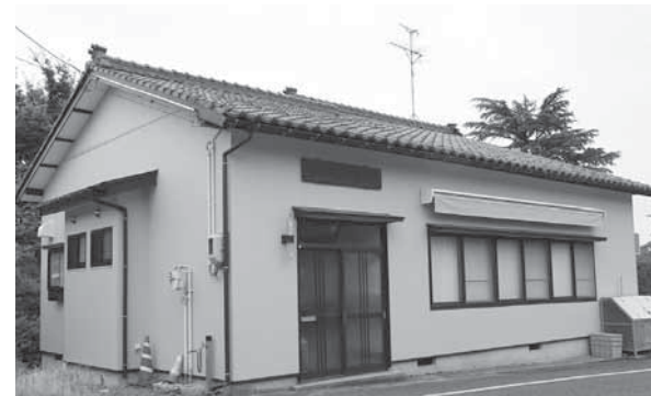
▲町内会等集会所建設費補助金で改修した大川前公民館
