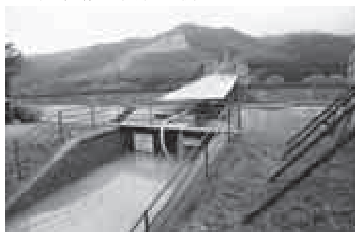
▲佐取地内。堤内の内水を抜くため、排水ポンプを設置して対応。
