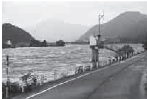
▲13日、午前10時頃の阿賀野川（馬下水位観測所）。最高水位は9時40分に観測された23.18mであり、目測で道路までと約2mに迫った。
