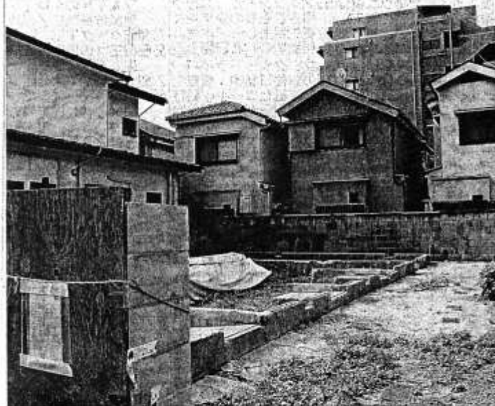
強制撤去され、基礎だけが残る空き家の跡地。持ち主にあてた近隣住民名の張り紙(左下)があった一東京都大田区で
