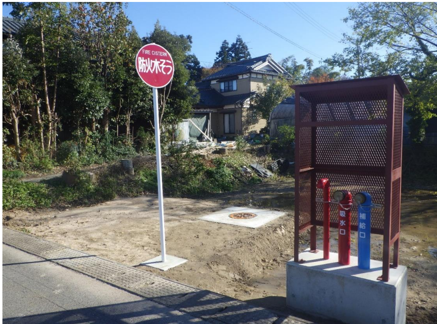
令和5年新設防火水槽(一本杉地内)
