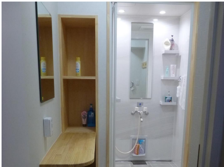
村松分署シャワーユニット設置工事
