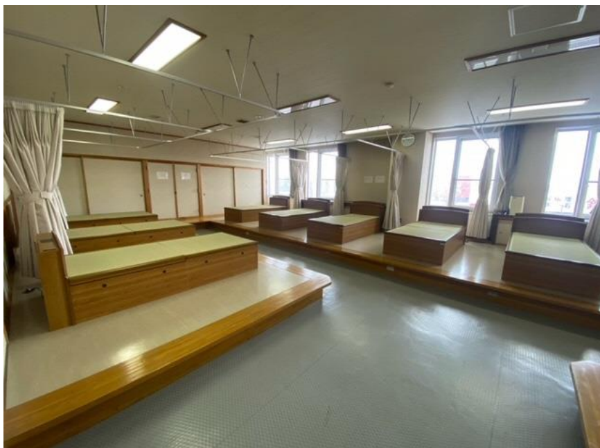
職員仮眠室改修工事
