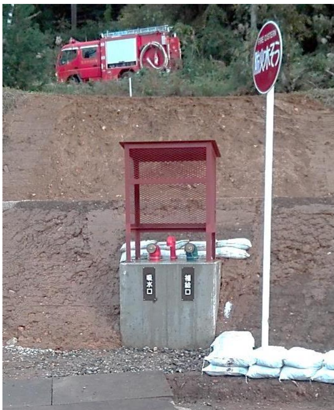
新設した耐震性貯水槽40m 3 型(高松)
