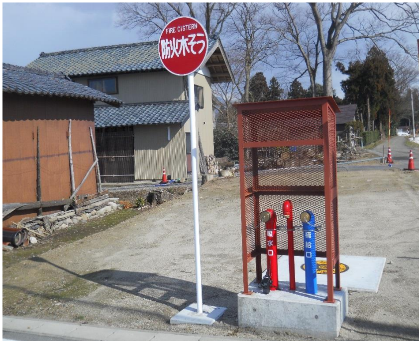
新設した耐震性貯水槽40m 3 型(上郷屋)
