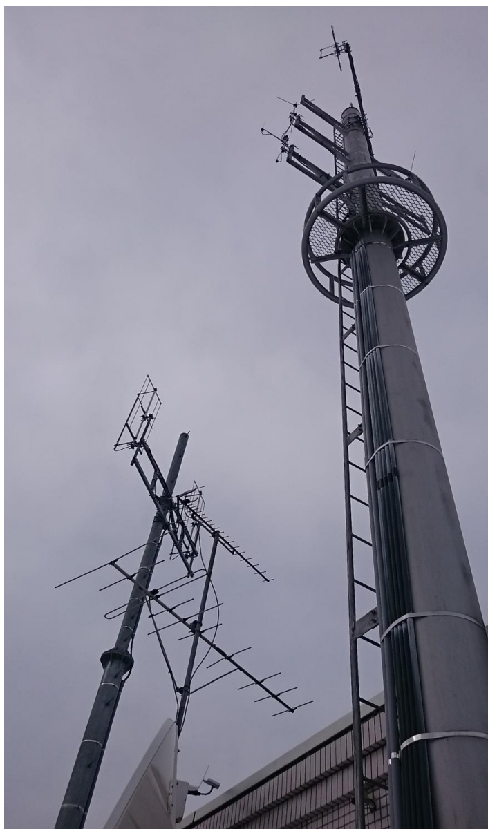
五泉市消防本部屋上の消防無線局
