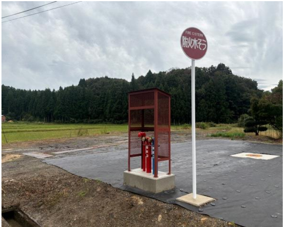
令和6年度新設防火水槽(寺田地内)
