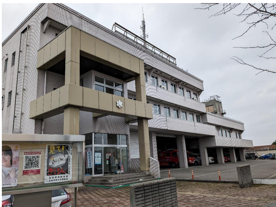
消防本部庁舎
