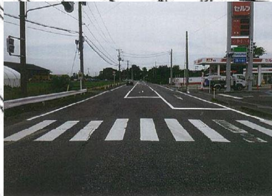
平成29年度②車線境界線の再表示完了
