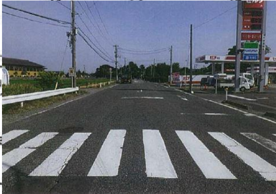
平成29年度②車線境界線の再表示前
